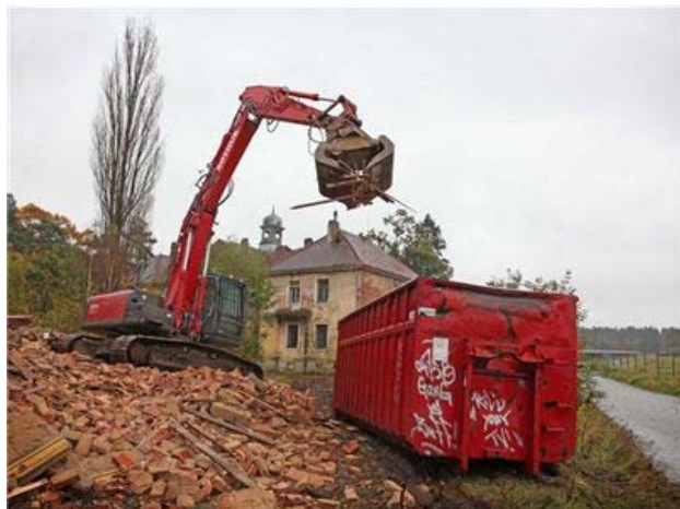
Ein großer Teil der Häuser im Neuen Lager wurden bereits abgerissen.
